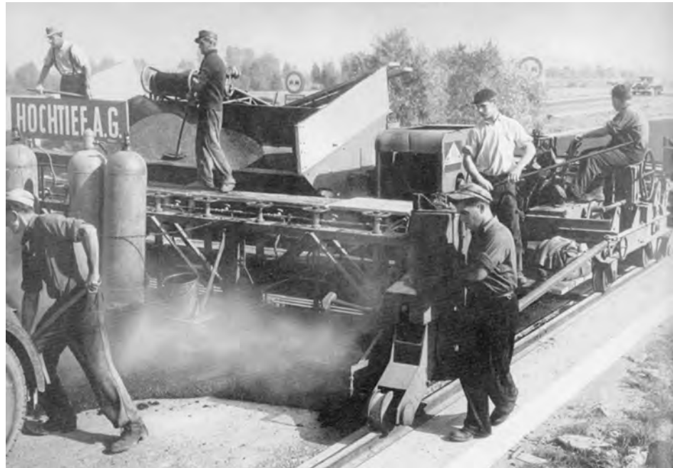
Neue Maschinen entlasten die Straßenbauer von der schweren körperlichen Arbeit: Gussasphalt-Maschine.
