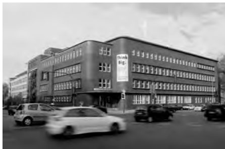
Verbandsgebäude des RVR an der Kronprinzenstraße in Essen Foto: RVR-Archiv
