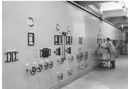
Schaltraum der neu errichteten Ammoniakanlage in Bottrop
