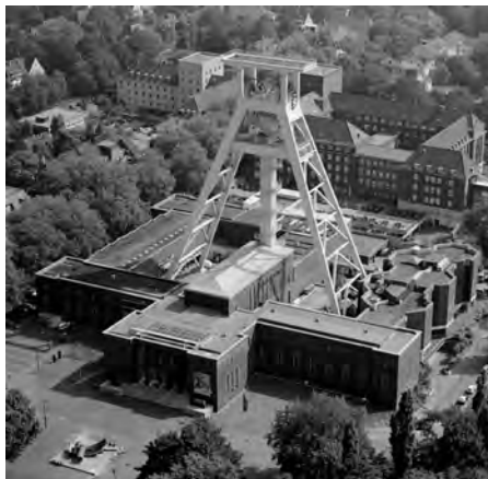
Schachtgerüst über dem Deutschen Bergbau-Museum Bochum. Foto: Bergbau-Archiv Bochum
