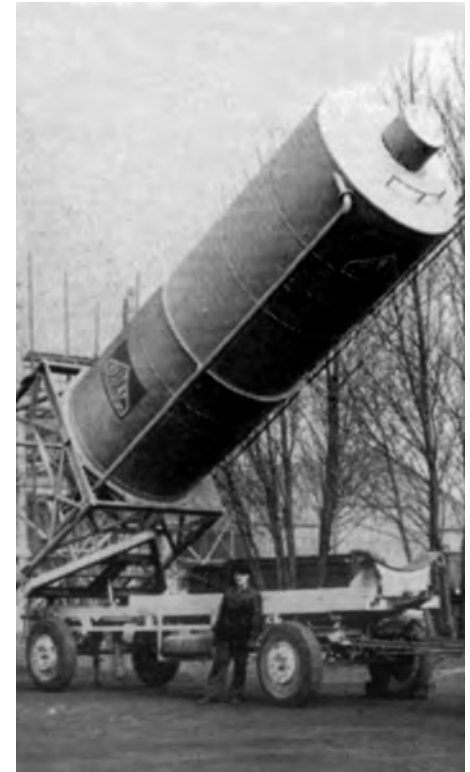
Ein speziell entwickeltes Fahrzeug bringt den Zementsilo an die Baustelle. Das Aufstellen erfolgt durch einen Schwenkhebel am Fahrzeug, den der Fahrer allein bedienen kann.
