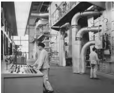
Blick in das Kesselhaus des neuen Hochdruck-Dampfkraftwerks der Hüttenwerk Oberhausen AG, nach 1954 Foto: Hermann Harz GmbH, Düsseldorf/ThyssenKrupp Konzernarchiv
