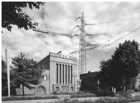
Das Umspannwerk Recklinghausen: aktive Betriebsstätte, Standort des Museums „Strom und Leben“ und des Unternehmensarchivs der RWE Westfalen-Weser-Ems AG Foto: Archiv der RWE Westfalen-Weser-Ems AG
